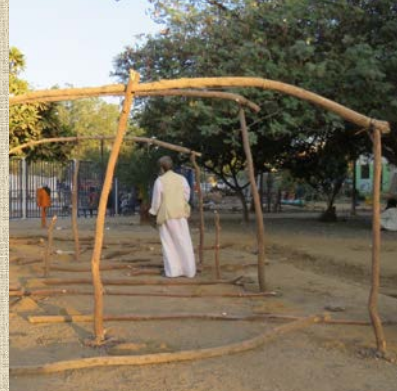
الخشب الرأسى (الغزاز) من النيم Vertical skeleton from Neem
