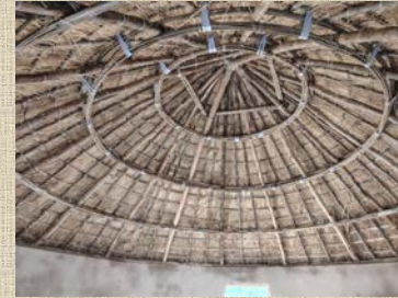
النبات المستخدم في الاعمدة الرأسية للهيكل من البان والسدر والقنا The plant used in the vertical columns of the structure is made of Bann, Sidr and Ganna.
