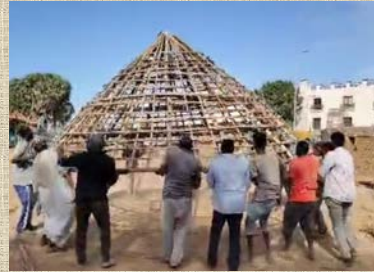
النبات المستخدم في الاعمدة الرأسية للهيكل من البان والسدر والقنا The plant used in the vertical columns of the structure is made of Bann, Sidr and Ganna.
