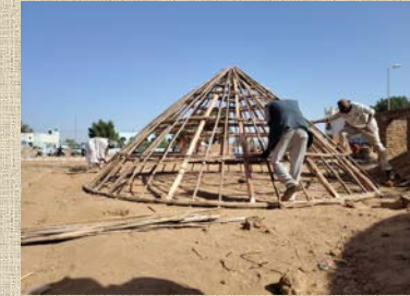
النبات المستخدم في الاعمدة الرأسية للهيكل من البان والسدر والقنا The plant used in the vertical columns of the structure is made of Bann, Sidr and Ganna.
