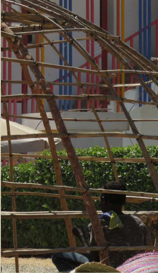
الخشب المستخدم في الدوائر الأفقية (المطارق) سدر Wood used in horizontal circles from Sidr
