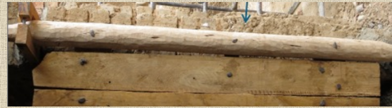
ركيزة الباب من خشب النيم Door frame from Neem
