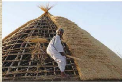
السقف من النال Roof from Nal
