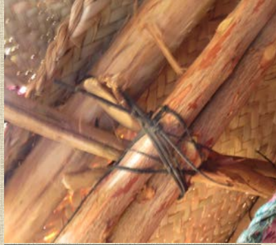
الخشب الأفقي من السدر Horizontal wood from Sidr
