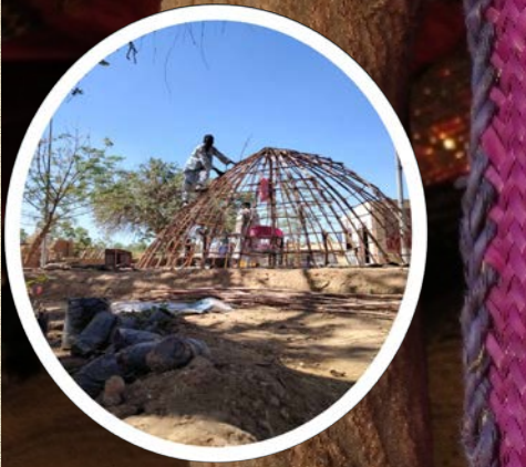
الخشب الأفقي من السدر Horizontal wood from Sidr
